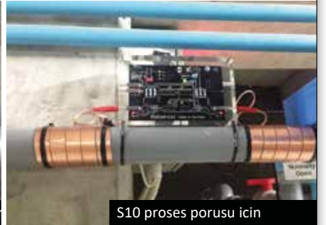
Boru izolasyonu ile kaplanmış implus bantları
