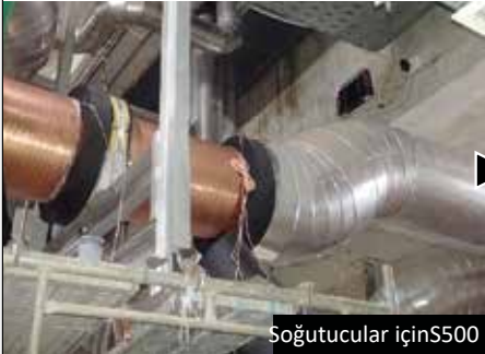
Boru izolasyonu ile kaplanmış implus bantları
