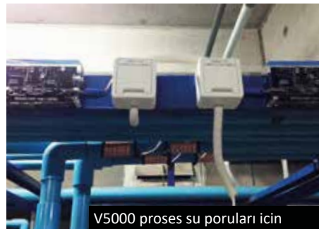
Boru izolasyonu ile kaplanmış implus bantları
