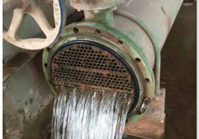
2 ay Vulcan kurulumundan sonra ısı eşanjörü
