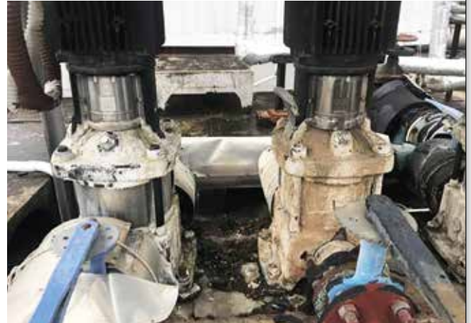
Solda, Vulcan S25'in 2 ay boyunca kurulmasından sonraki boru (kireçsiz); sağda ise herhangi su arıtımı olmayan boru bulunuyor.
