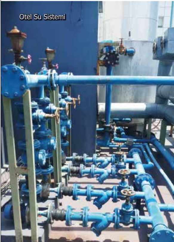
Vulcan S25, su şebekesi borusu üzerinde kuruldu.
