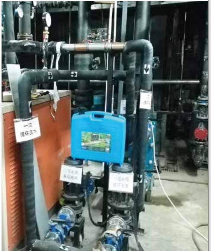
Vulcan S10 otelin sıcak su sisteminde kuruldu
