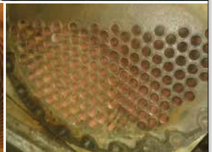
Soğutma kulesi su borusu üzerinde Vulcan S500
