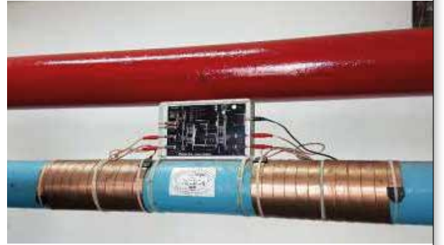
Kireç Önleyici Sistem Vulcan S25 kuruldu
