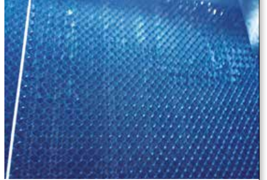
Vulcan ile 3 hafta sonra CT-1'in iç kısmı. Vulcan ile artılmış suyla sürekli temas halinde olan temiz olukları ve hala bir miktar yeşil biyofilm bulunan birkaç kuru (artılmamış) alanı göstermektedir.
