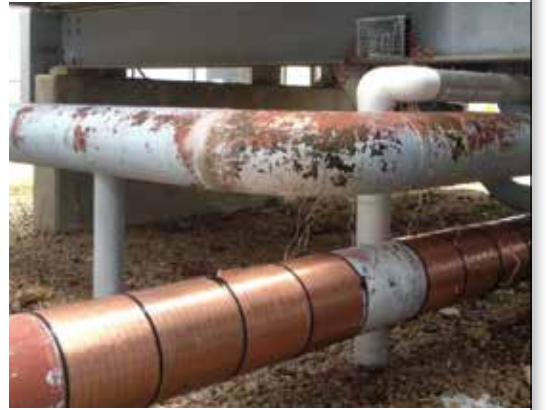
Vulcan S250, ikiz soğutma kulelerini besleyen 10 inç çaplı bir hat üzerinde kuruldu (CT-1 ve CT-2)
