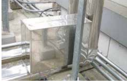
Vulcan S25; A, B ve C soğutma kuleleri için katma suyu borusu üzerine kuruldu.
