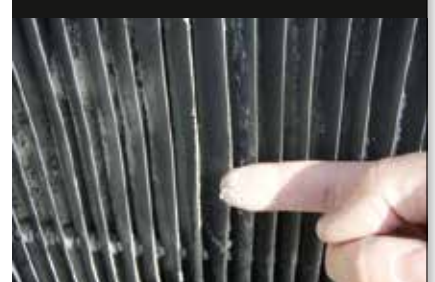
Silika, yüksek basınçlı su tabancası ile çıkarılabilir ve kalan silika parmakla çıkarılabilir.
