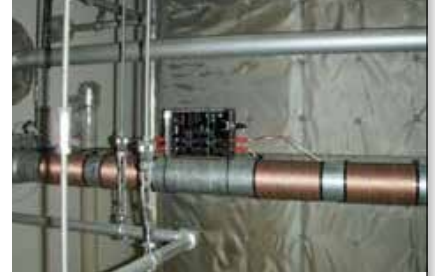
Vulcan S25, soğutma kuleleri C için sirkülasyon su borusu üzerine kuruldu.
