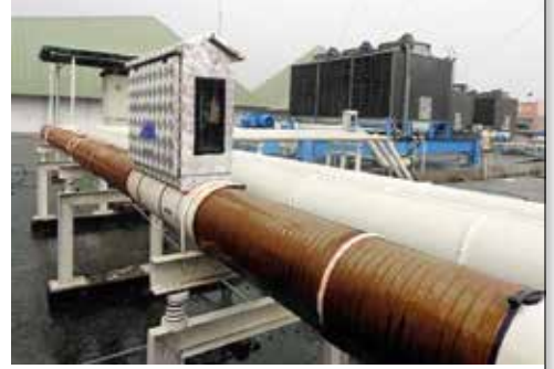
Vulcan S500, alüminyum kutunun içine yerleştirildi ve bir soğutma kulesi ana borusu üzerine kuruldu.
