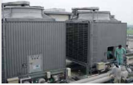
Soğutma Kulesi A Soğutma Kulesi B
