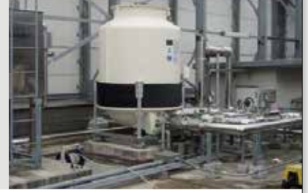
Soğutma Kulesi C
