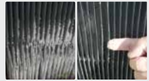
Soğutma kulesi izgaraları
